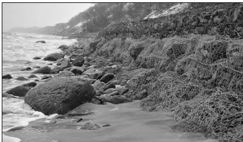
Рис. 4. Состояние габионов у г. Светлогорска после четырех лет эксплуатации
